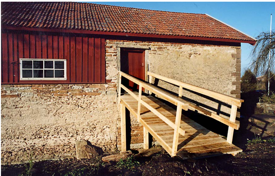
Gångbron underlättar tillgängligheten till norra rummet, som annars är lite krångligt att nå. Nov. -07.
